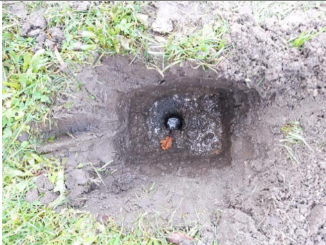
Foto 2: Deellocatie 1 – proefgat boring 1006
