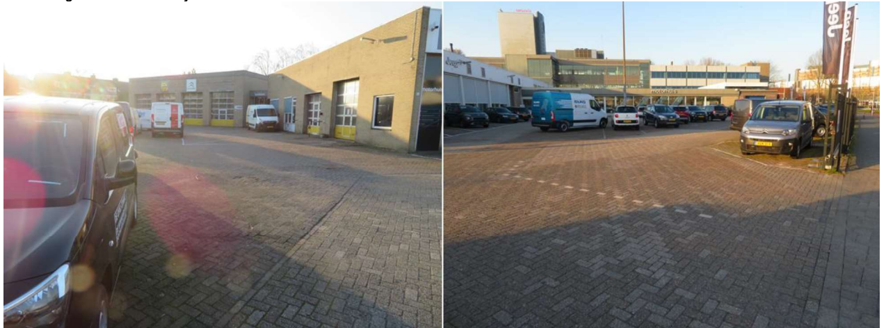
Afbeelding 5a en 5b: Achterzijde deellocatie 1
