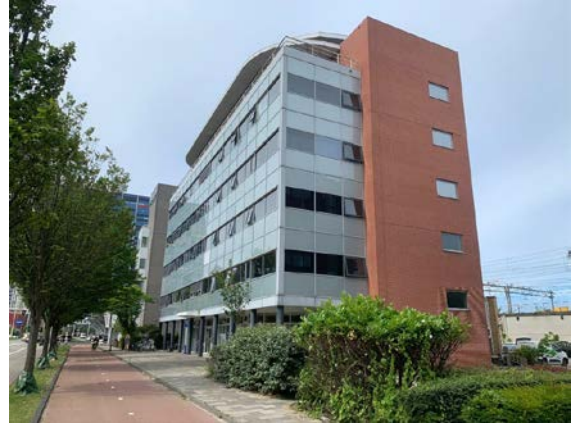
Bebouwing Schipholweg 68 en overzicht openbaar gebied (trottoir)
