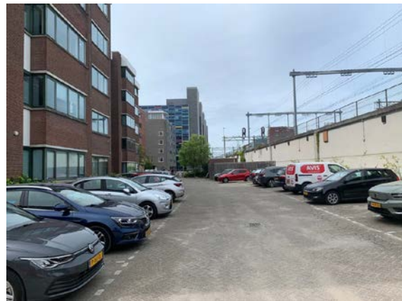
Overzicht buitenterrein noordzijde, grotendeels verhard en voorzien van parkeerplaatsen. Tussen de noord- en zuidzijde bevindt zich een groenstrook
