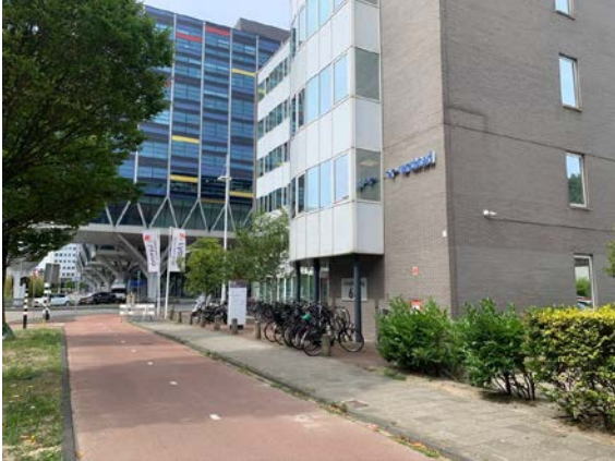
Bebouwing Schipholweg 66 en overzicht openbaar gebied (trottoir)
