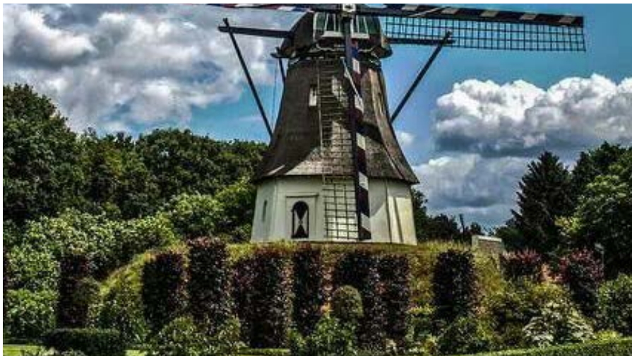
“Referentiebeelden die een sfeer geven naar de mogelijkheden van het landschap rondom molen De Herder”
