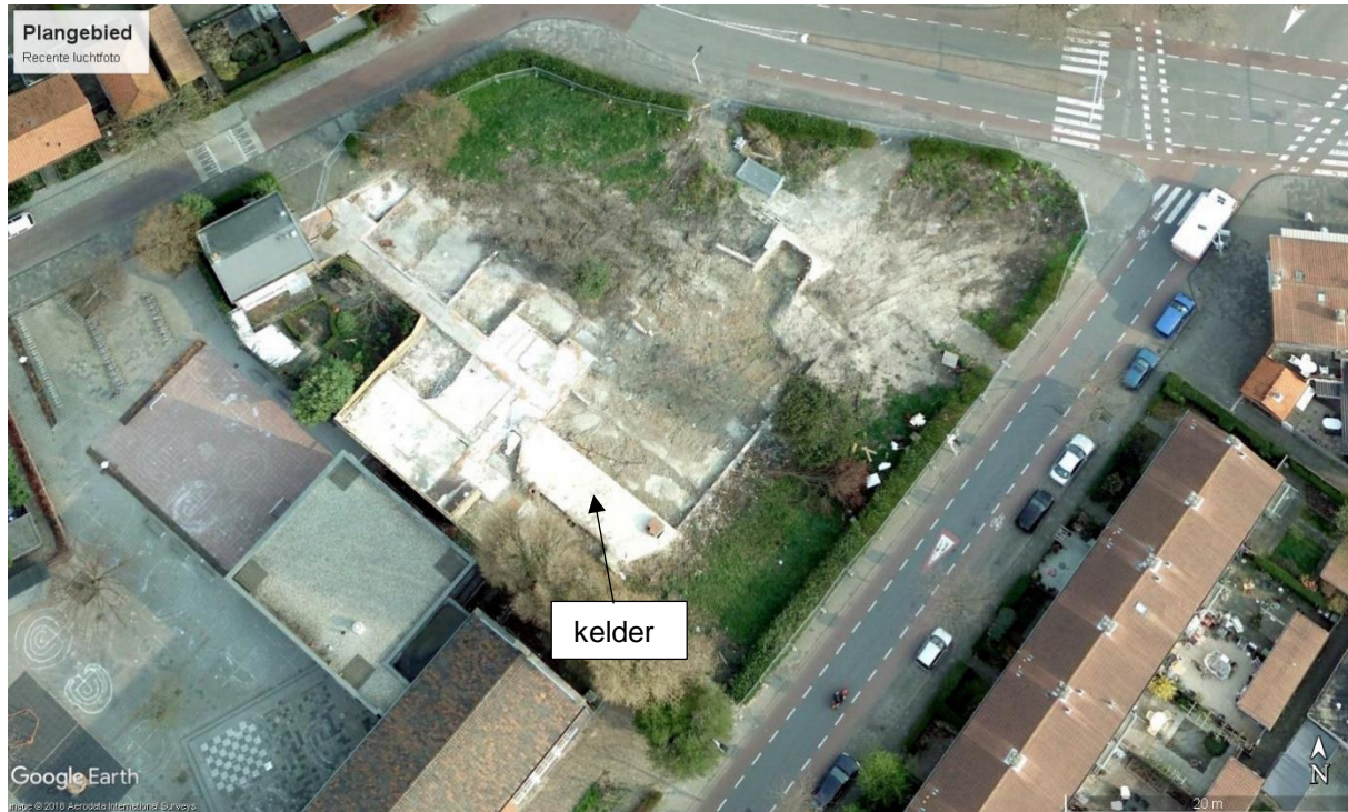
Figuur 4: Recente luchtfoto van het plangebied waar funderingsmuren zijn nog zichtbaar. Bron: Google Earth.
