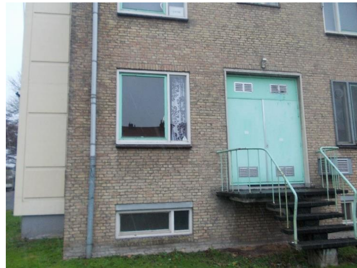
Detail linker geveldeel Ter Haarkade
