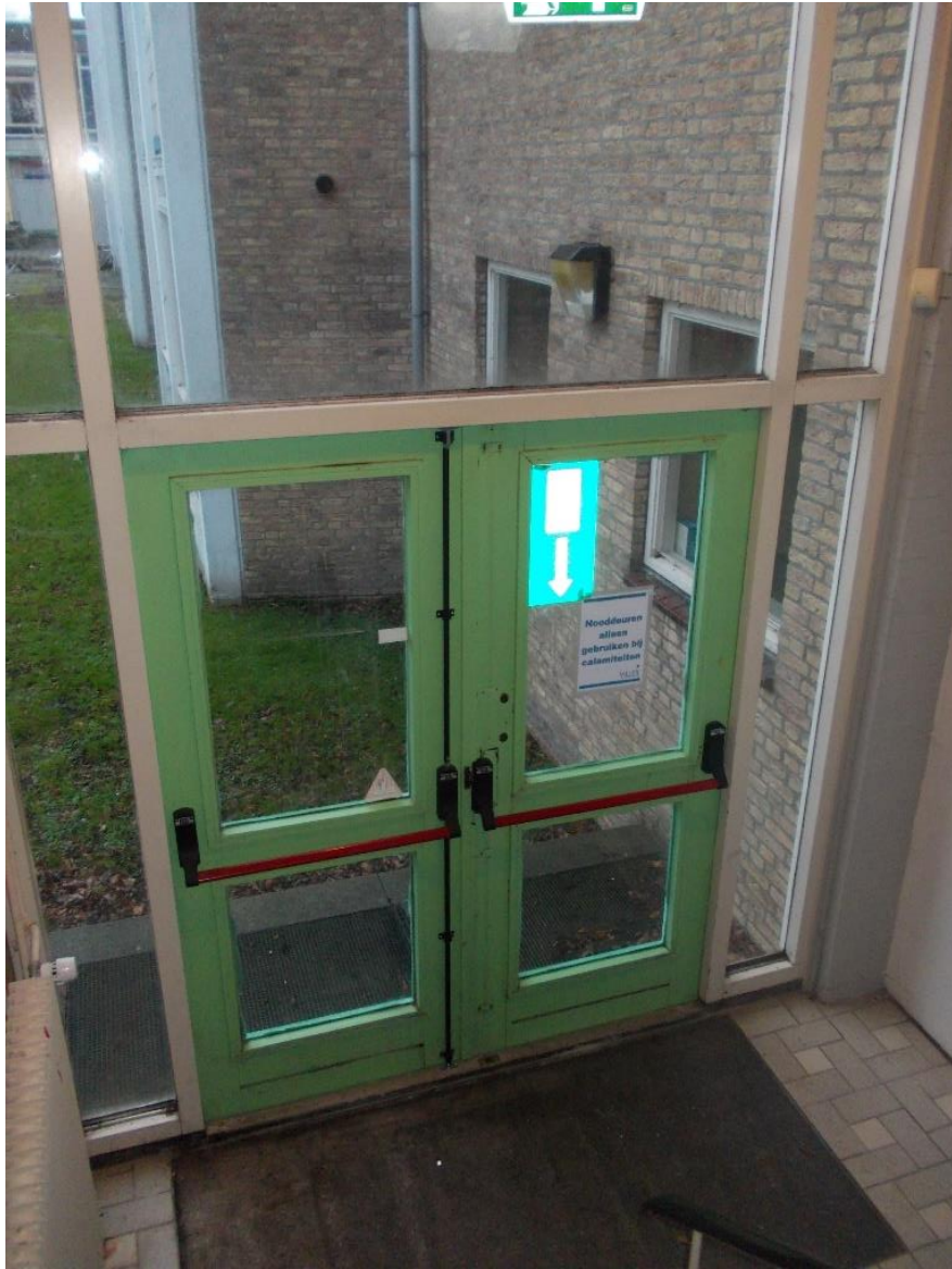
Deur op begane grond vanuit trappenhuis gezien
