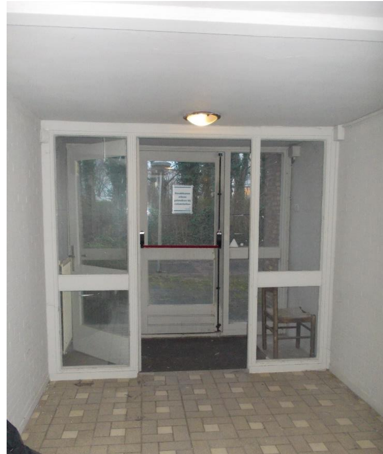
Deur (achterzijde bouwdeel 2)
