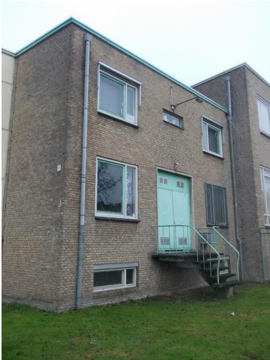
Linker geveldeel Ter Haarkade
