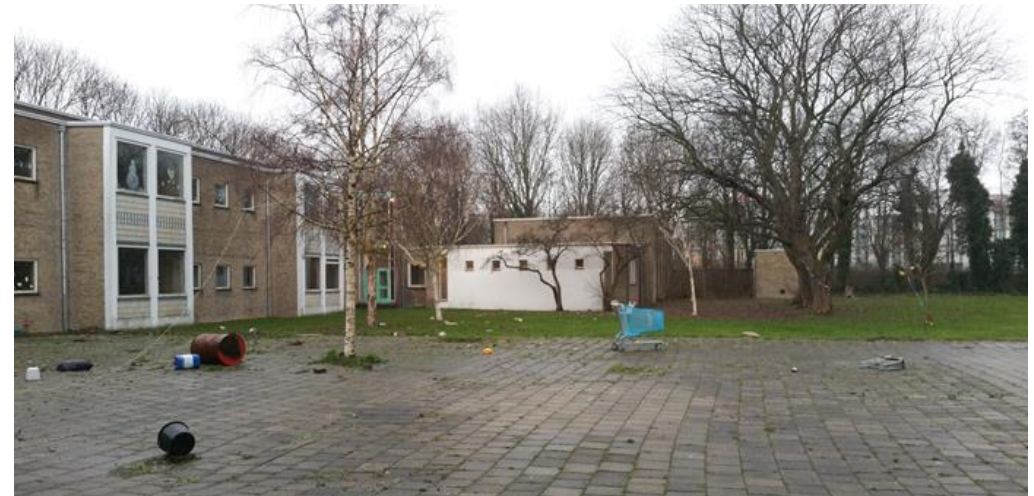
Zicht op de was- en kleedruimte met daarachter de gymzaal
