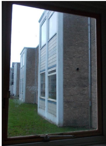
Achtergevel bouwdeel 1 vanuit raam
