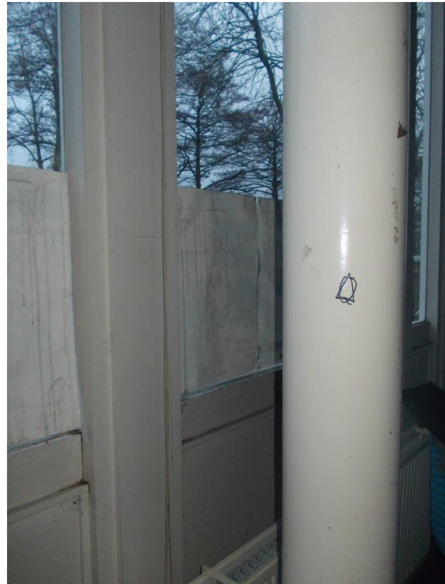
Detail pijler achter de vliesgevel
