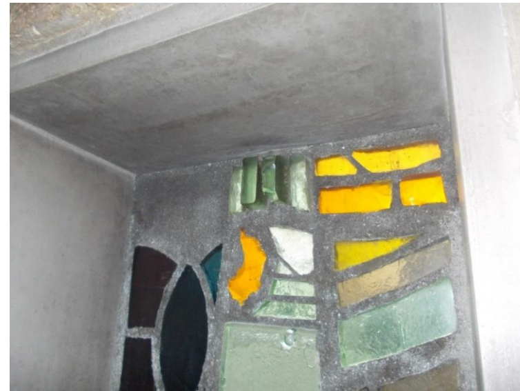
Detail van een van de glas-in-beton elementen
