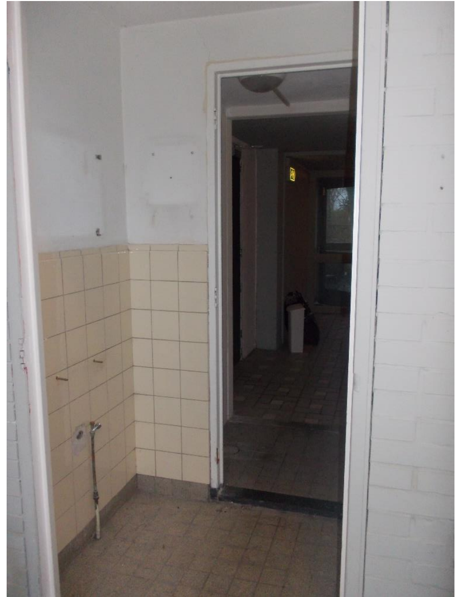
Overgangsruimte met oude fonteinafvoer
