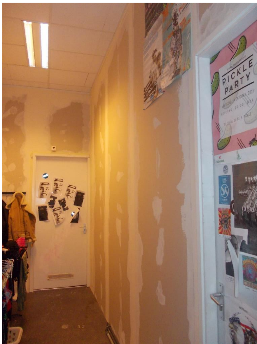
Recent geplaatste wand
