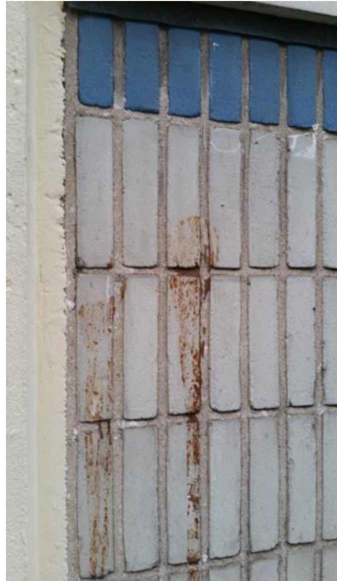
Detail geglazuurde baksteengevel (bevuild)
