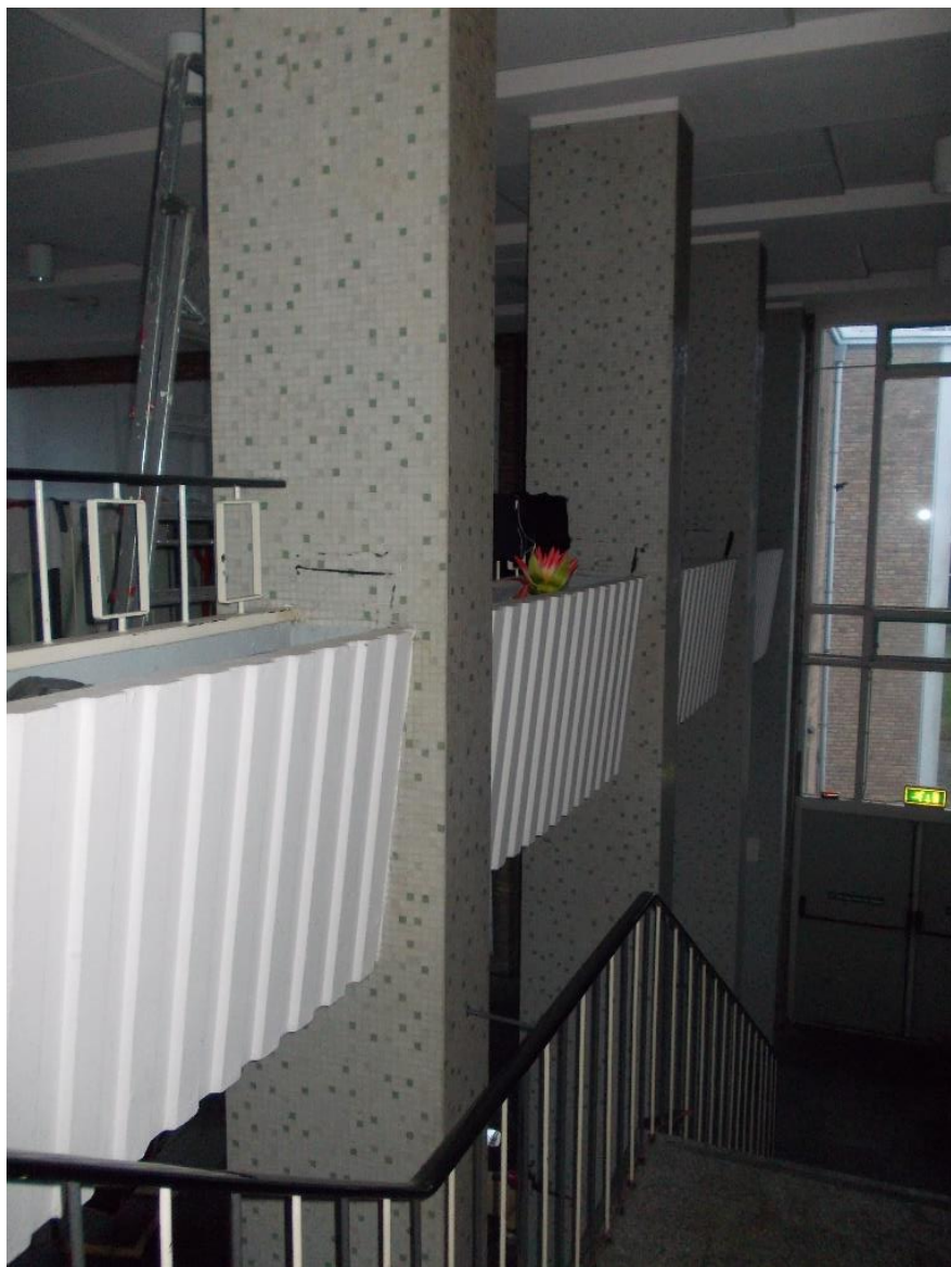
Gegoten geïntegreerde plantenbakken
