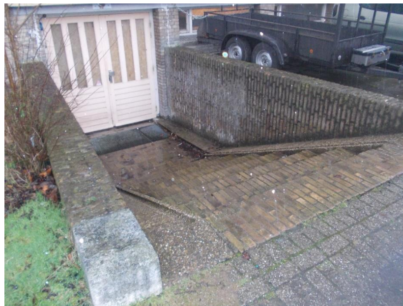
Ter Haarkade: neergaande trap met fietsgleuf richting kelder
