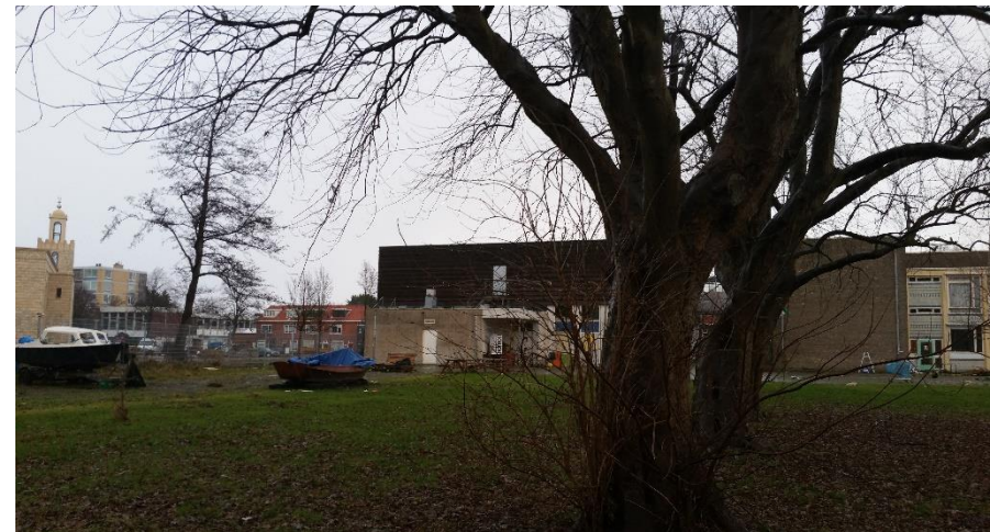
Zicht op moskee in aanbouw en nieuwbouwgedeelte school
