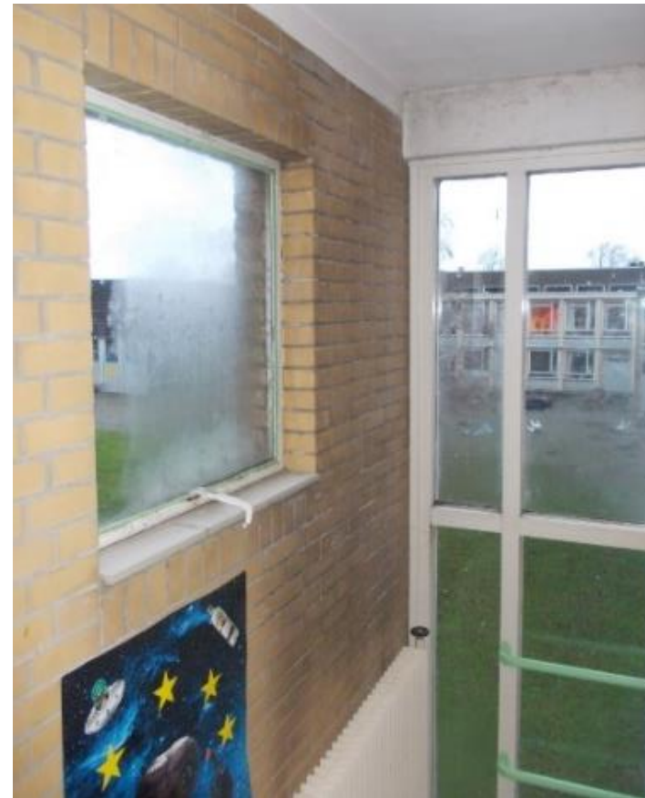
Kozijnen in trappenhuis
