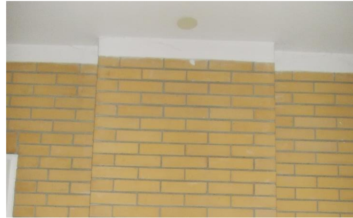
Detail penant in een van de gangen.
