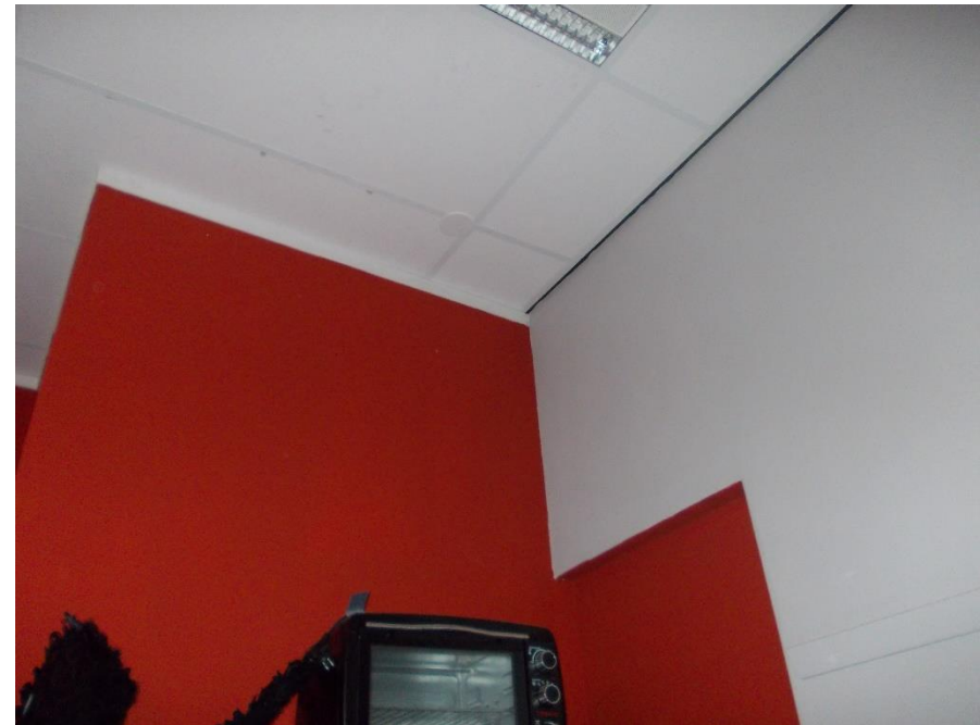
Detail plafond en wand kamer
