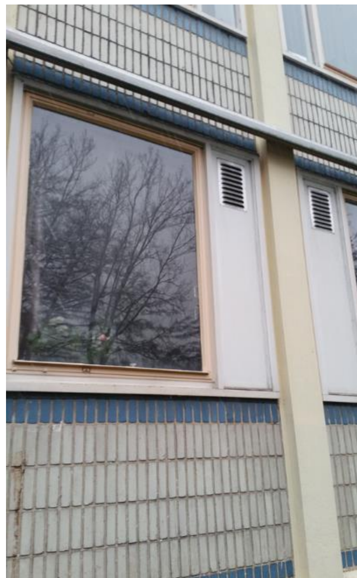
Detail kozijnen (plaatselijk dichtgezette ramen)
