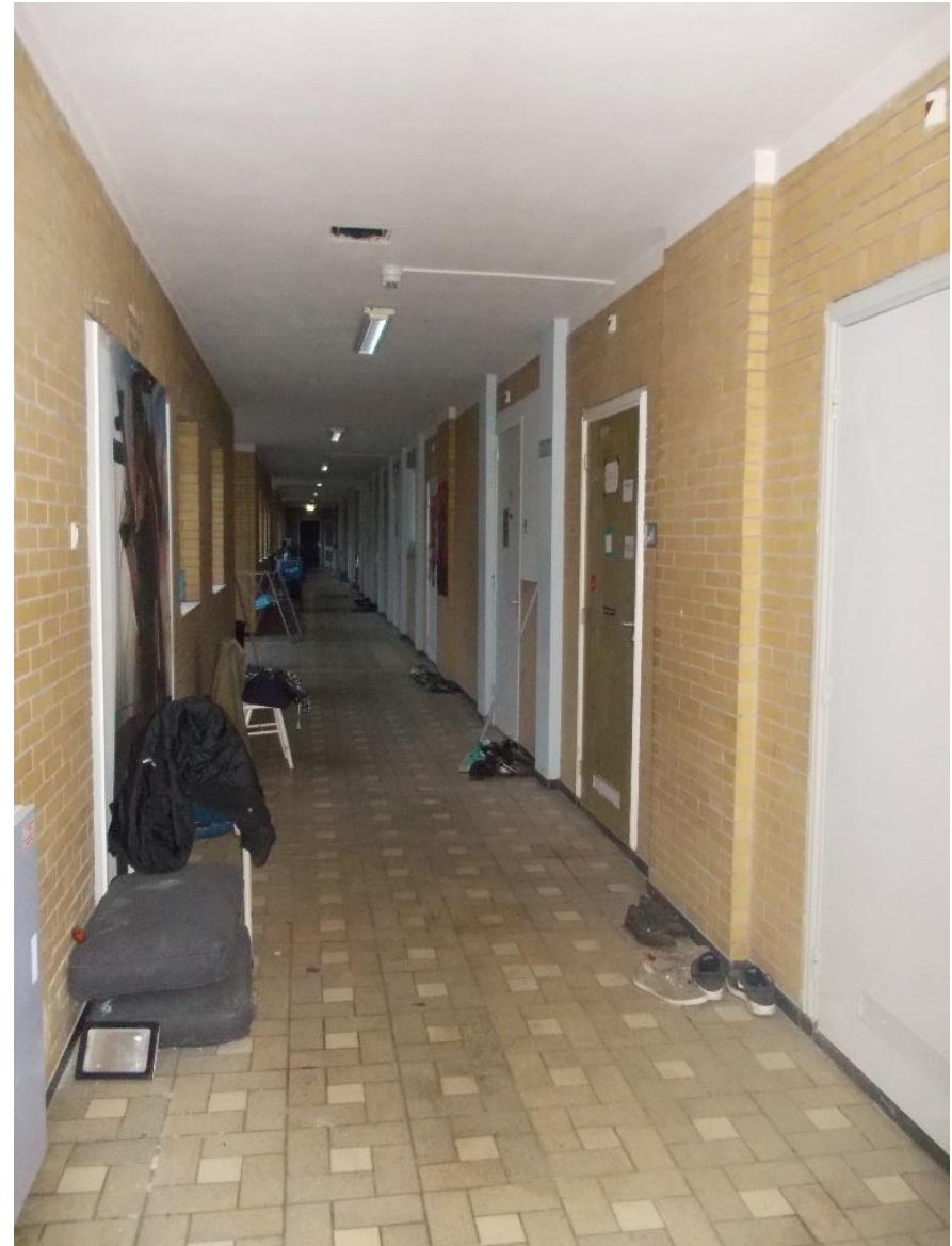
Gang gezien vanaf trappenhuis bij bouwdeel 2
