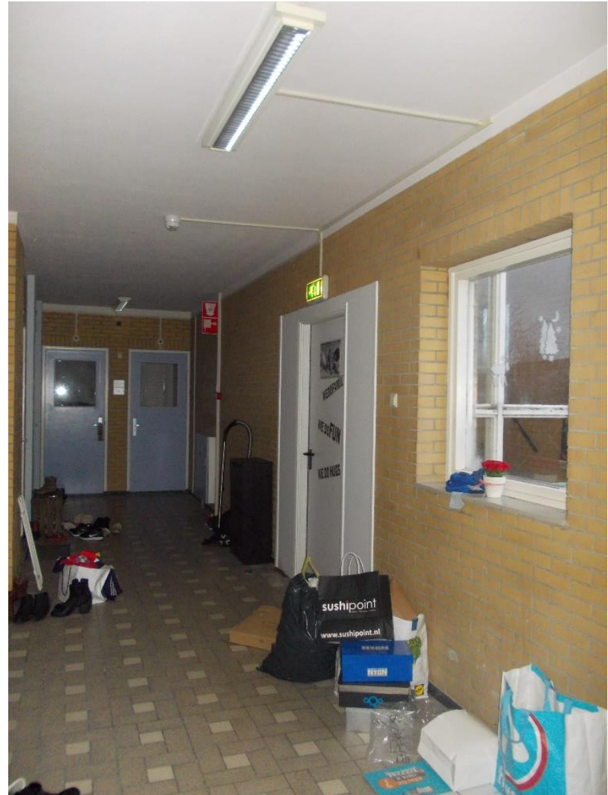
Detail gang bij toegang tot trappenhuis bouwdeel 2
