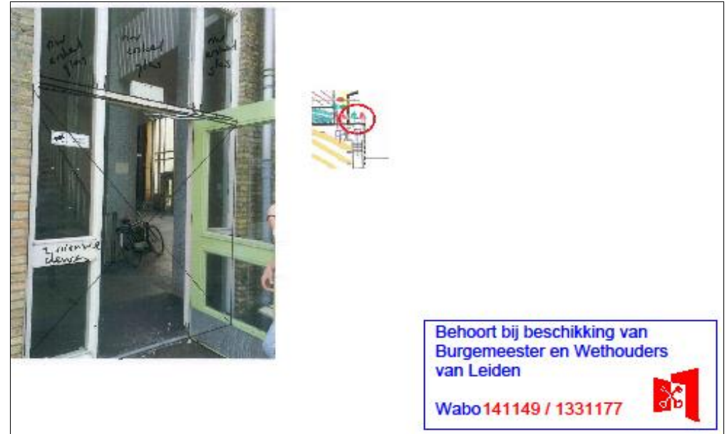
Deurvervanging achterkant hal tegenover opgang trap (bouwfase V)
