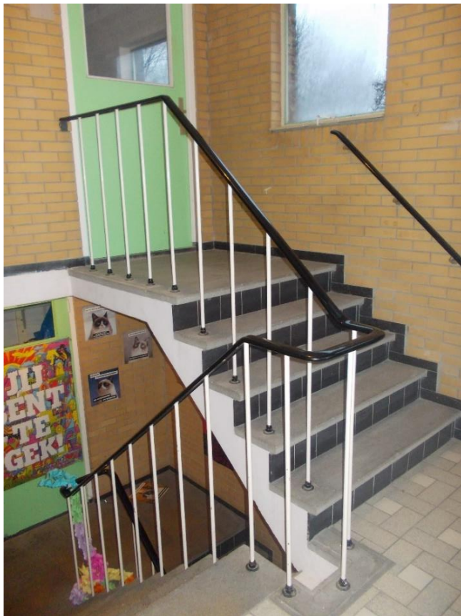
Trappenhuis tussen bouwdelen 1 en 2
