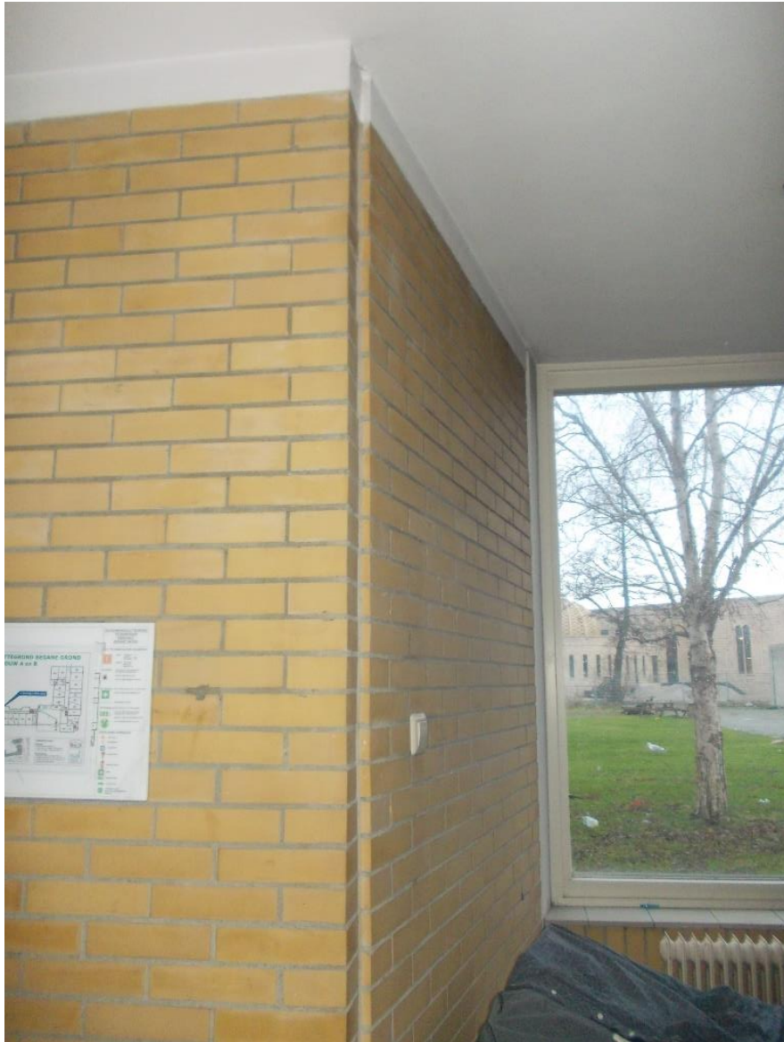
Detail metselwerk bij erker
