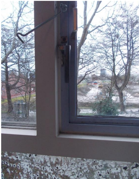
Kozijndetail staal in houten kozijn
