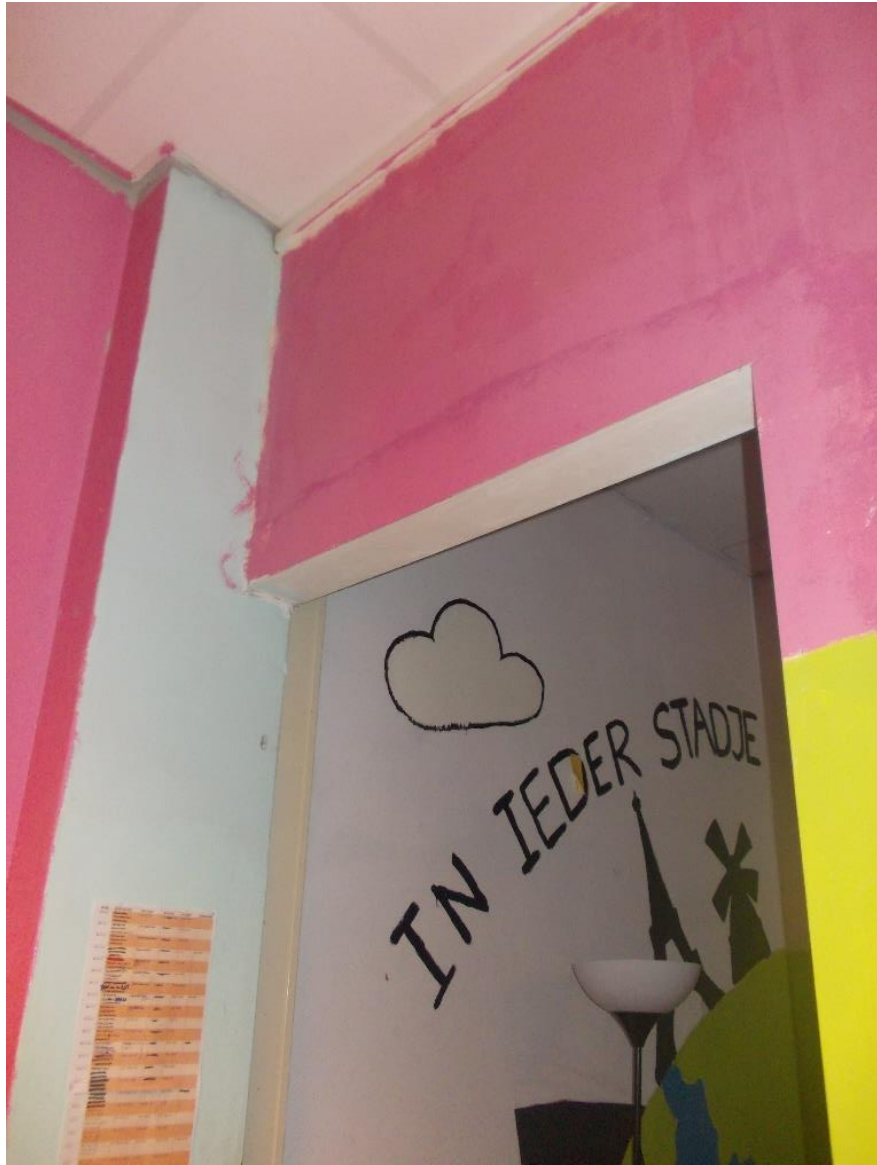
Systeemplafond en nieuwe wand
