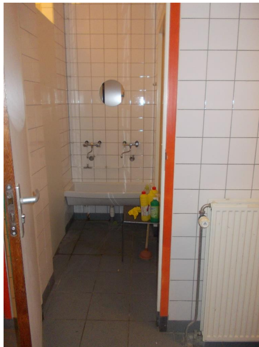
Wasbak in een van de cellen
