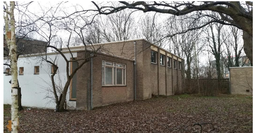
Zicht op was- en kleedruimte en gymzaal
