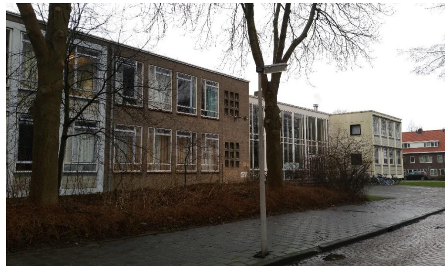
Deel voorgevel aan Toussaintkade (beide)
