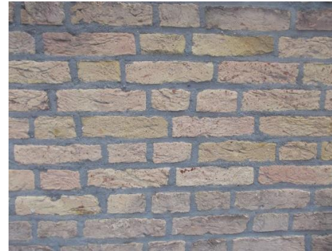
Detail baksteengevel (exterieur)
