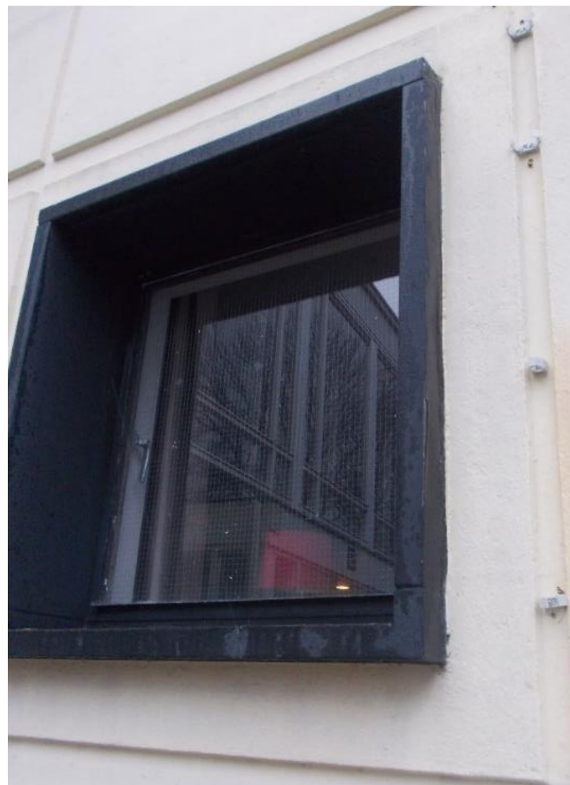
Detail raam in gevel naast toegangspartij
