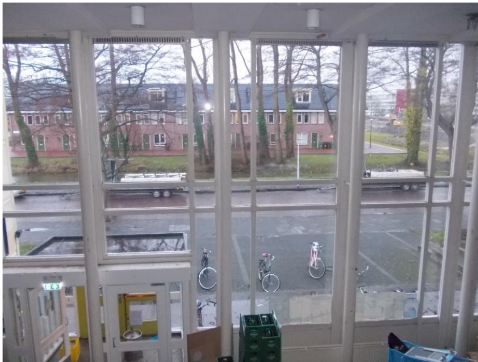
Vliesgevel hal met verticale en horizontale geleiding
