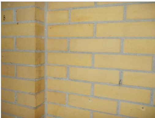
Detail schoon metselwerk gang
