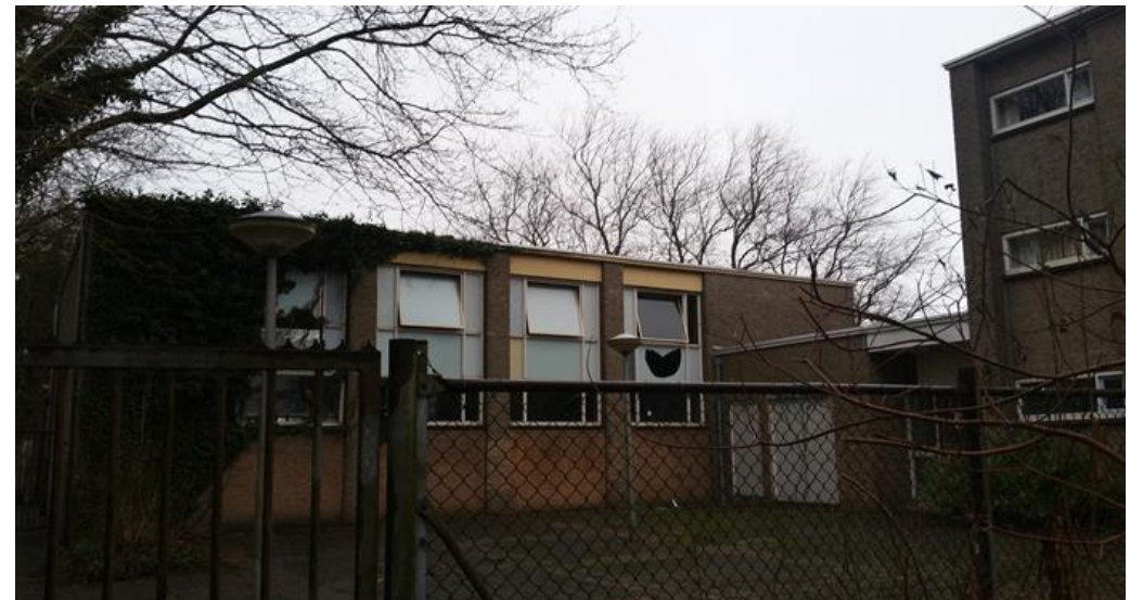
Zicht op bouwdeel 2, de gymzaal vanaf de Toussaintkade
