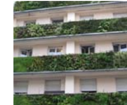
referentiebeeld "zachte" overgang naar bos: groene gevel door middel van begroeiende balkon.
