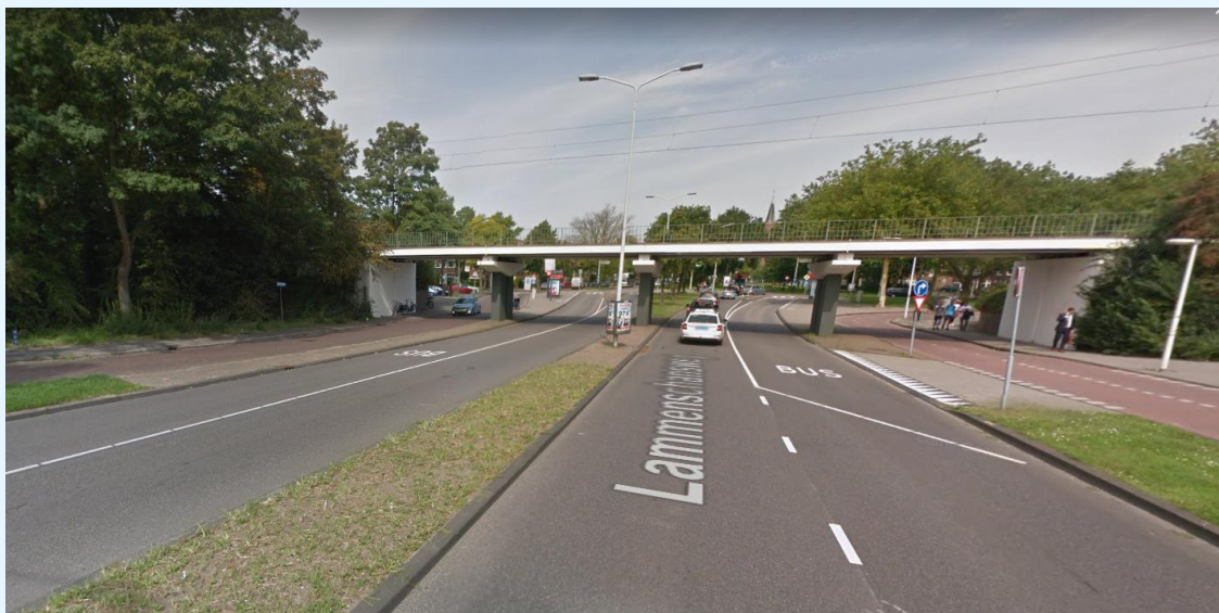
figuur 5: huidige stalen spoorbrug over Lammenschansweg
