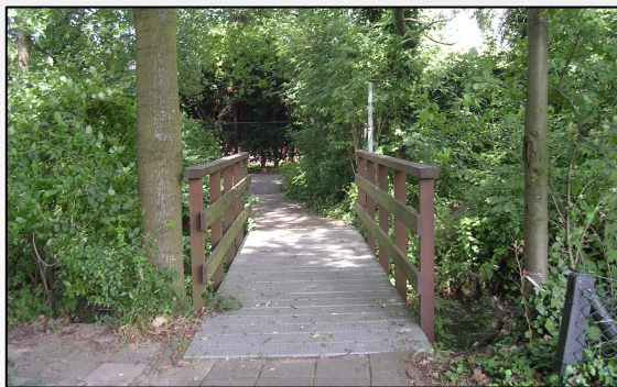
Brug met loopvlak van metalen rooster
