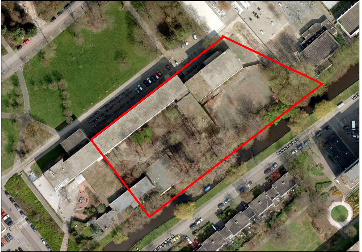
Figuur 2. Het Agnesgebouw. De rode lijnen duiden de beschermde situatie.
