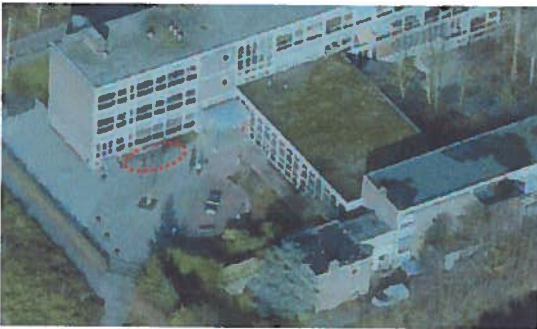
Foto opname deellocatie A voor de sloop
