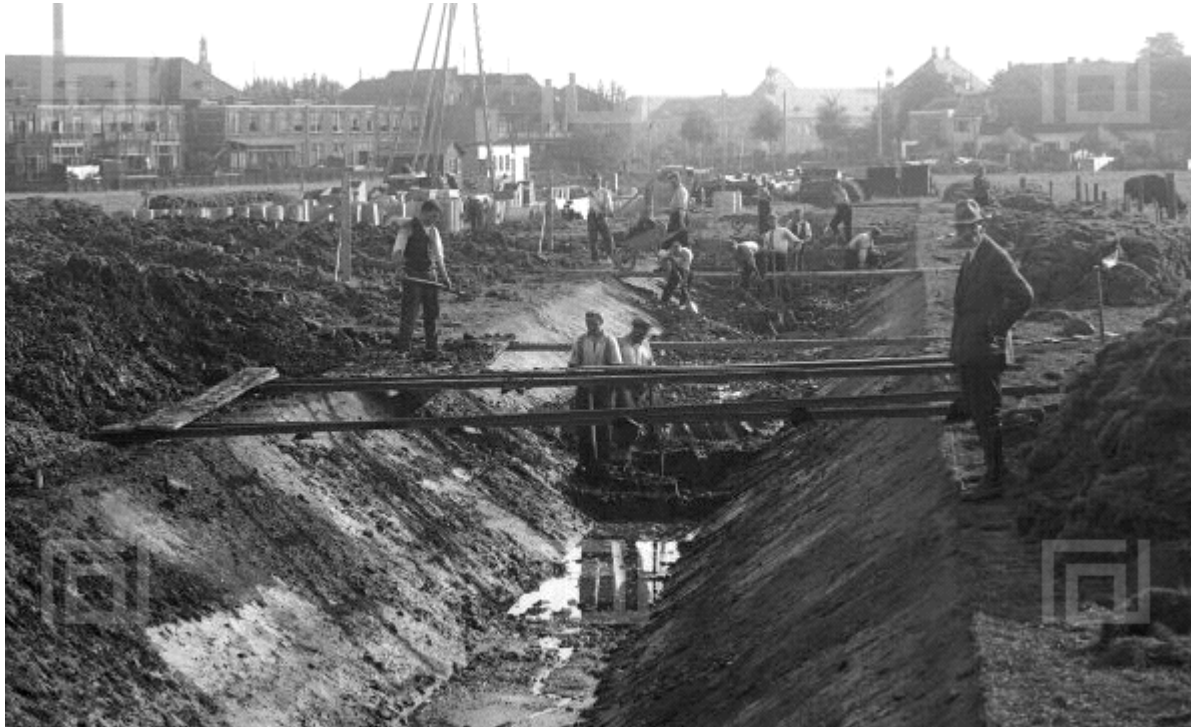
Afb. 2.2.2: Foto aanleg riolering in de Houtlaan (ongedateerd, na 1928 en voor 1940).
