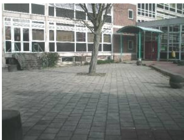
voormalige ligplaats van ondergrondse HBO-tank..
