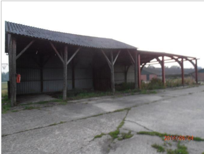
Schuur 1 (open machineschuur) Betreft een open machineschuur. Alleen in spleten in constructie is incidenteel verblijf van vleermuizen mogelijk.
