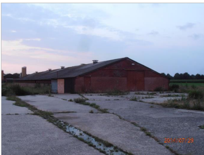
Schuur 3 (voormalige kippenschuur) Schuur 3 is een grote voormalige kippenschuur. In de voorruimte en schuur zijn aan de binnenkant muren en dak volledig dichtgespoten met pur-schuim. Aan de ZO-zijde is de buitenzijde aan kopse kant betimmerd met houten planken. Hier bevinden zich openingen met invliegmogelijkheid voor vleermuizen. Langs de zijden van de kippenschuur zijn openstaande ventilatieroosters. Via deze ventilatieroosters is vrije invlieg-mogelijkheid tot de kippenschuur. De luiken van de ventilatieroosters zijn open. Achter deze luiken is verblijfplaats
