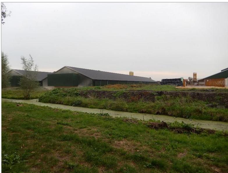
Nieuw gebouwde schuren ten noorden van projectgebied
