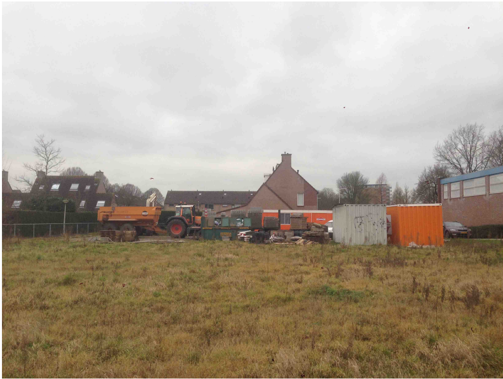
Figuur 3 Een deel van het terrein is in gebruik bij een aannemer in de grond-, weg- en waterbouw die verderop bezig is met wegwerkzaamheden.
