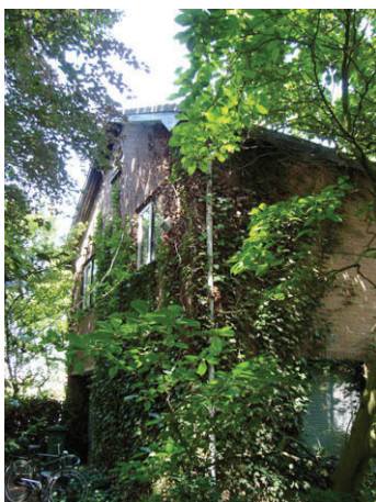
Foto 3: Te slopen woning in de noordwesthoek van het terrein.
