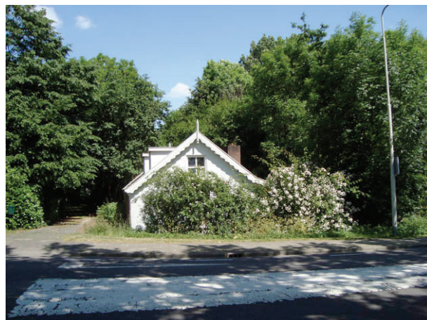
Foto 2: Te slopen woning aan de Industrieweg.
