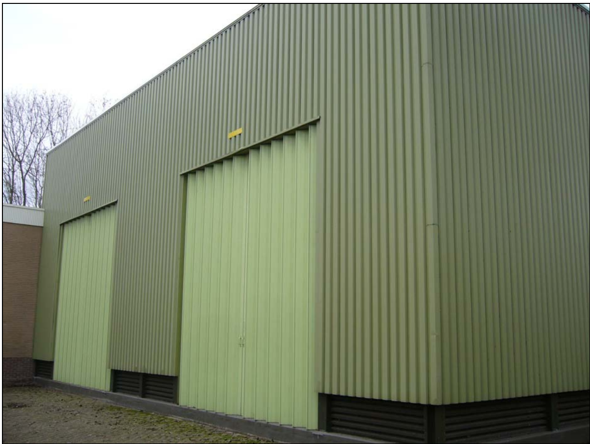
Figuur 4.1. Het transformatorgebouw.
