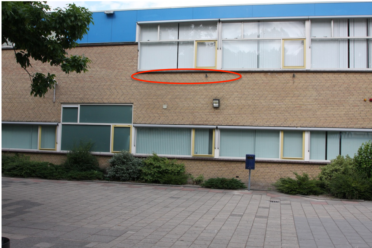
Afbeelding 8 Potentiele vaste rust- en verblijfplaats in spouwmuur toegankelijk door open stootvoegen
