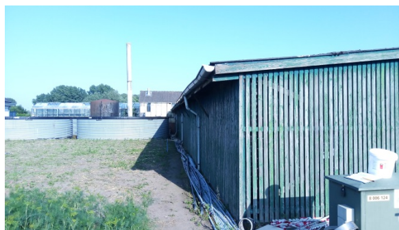
Foto 2: Onderzoekslocatie gezien in westelijke richting met op de voorgrond de schuur met de (deels) aanwezige dakgoot.
