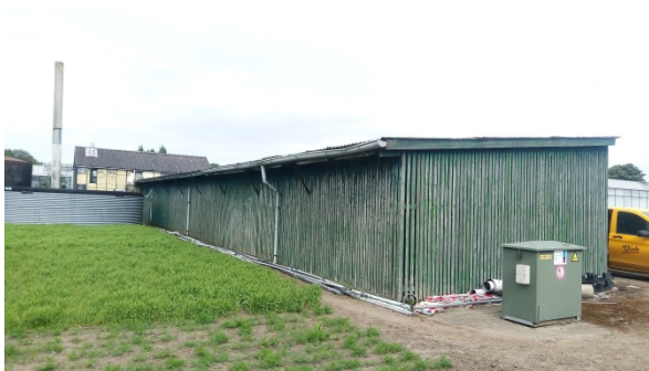
Foto 1: Overzicht onderzoekslocatie (foto genomen tijdens eerder uitgevoerd verkennend onderzoek asbest; situatie nog steeds onveranderd).
