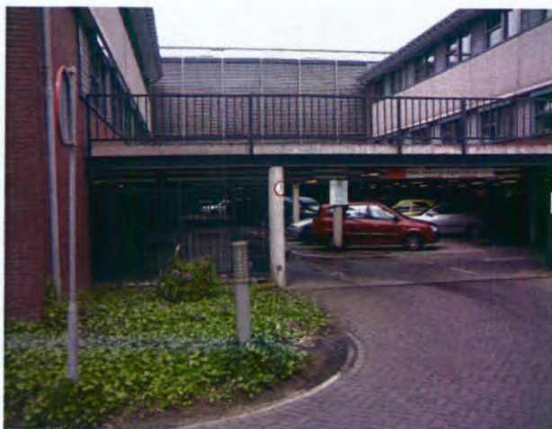
Afbeelding 3_1: Een (mee)gebouwde parkeervoorziening
