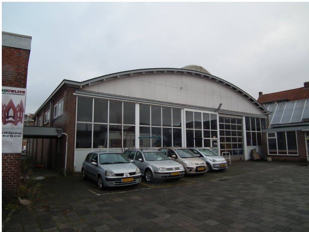
Figuur 2 Op de planlocatie is tevens een voormalige garagelocatie gesitueerd.
