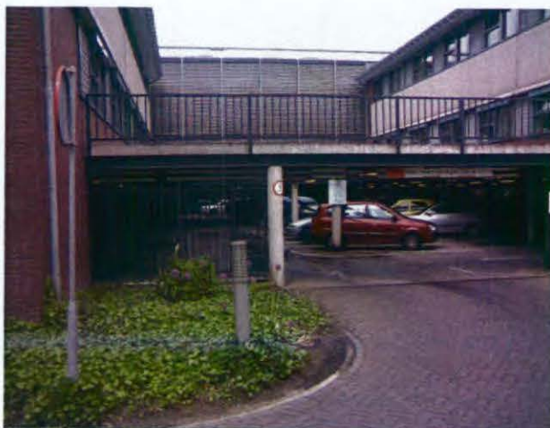
Afbeelding 3_1: Een (mee)gebouwde parkeervoorziening
