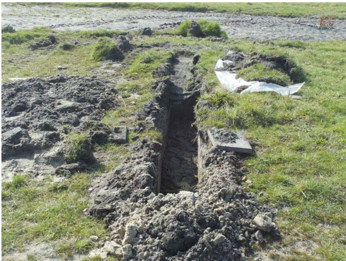
Foto 13: Duivallei te Katwijk, Asbestonderzoek
