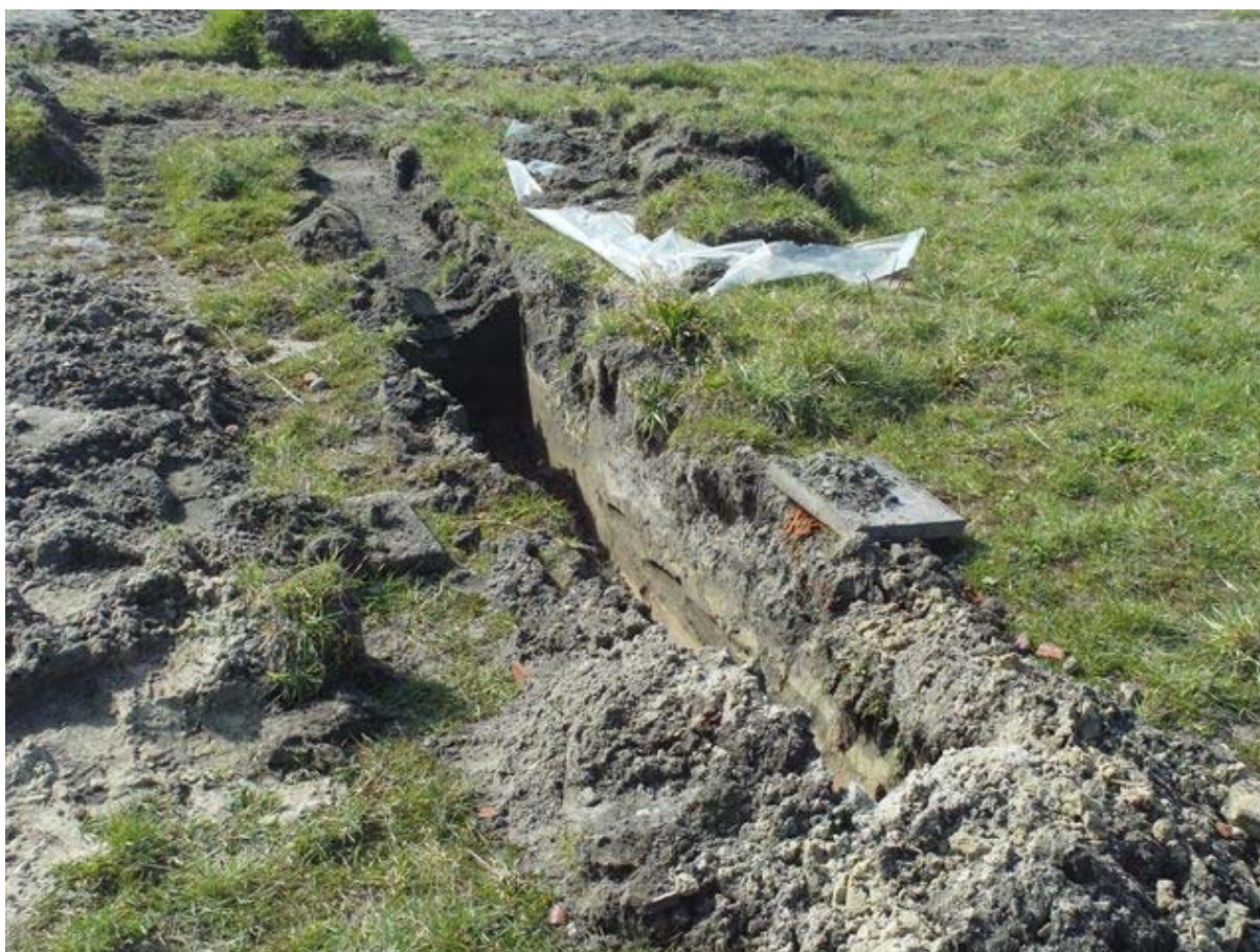
Foto 14: Duivallei te Katwijk, Asbestonderzoek
