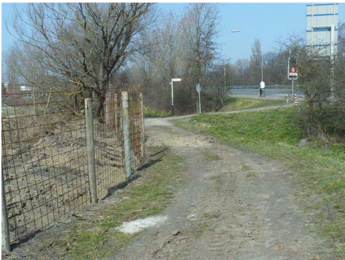
Foto 6: Duivallei te Katwijk, Asbestonderzoek
