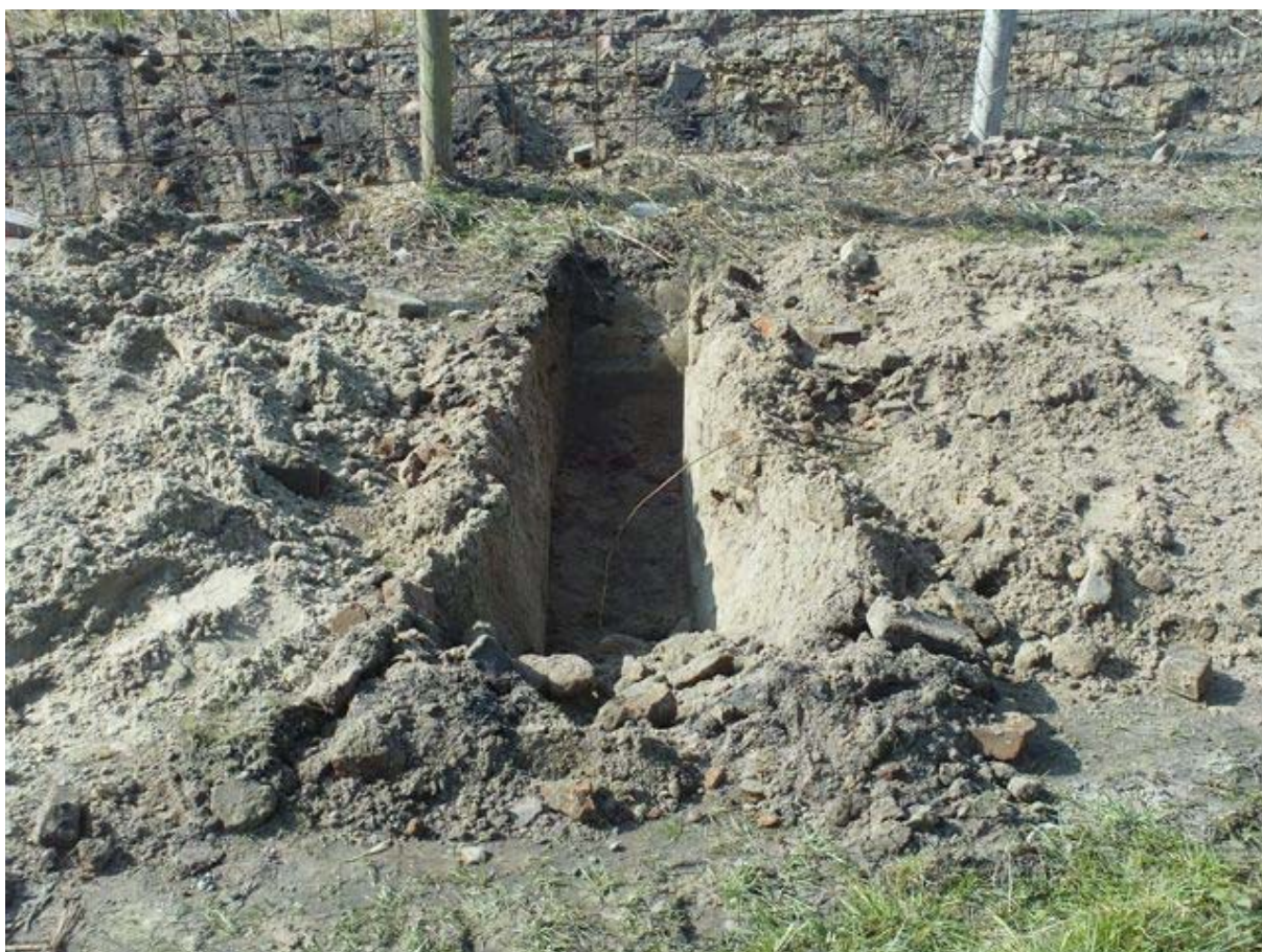
Foto 8: Duivallei te Katwijk, Asbestonderzoek
