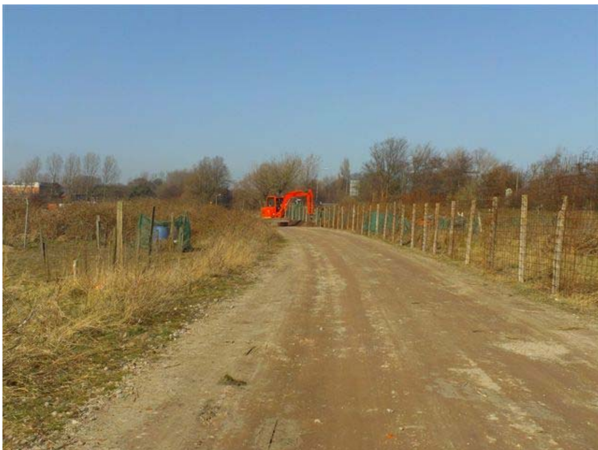
Foto 2: Duivallei te Katwijk, Asbestonderzoek
