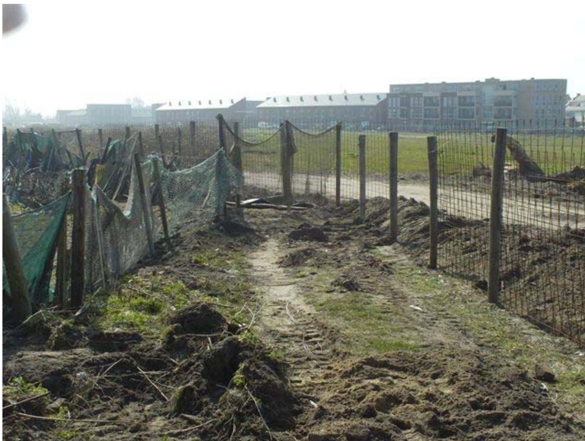
Foto 7: Duivallei te Katwijk, Asbestonderzoek
