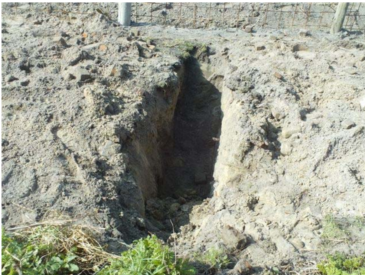
Foto 11: Duivallei te Katwijk, Asbestonderzoek
