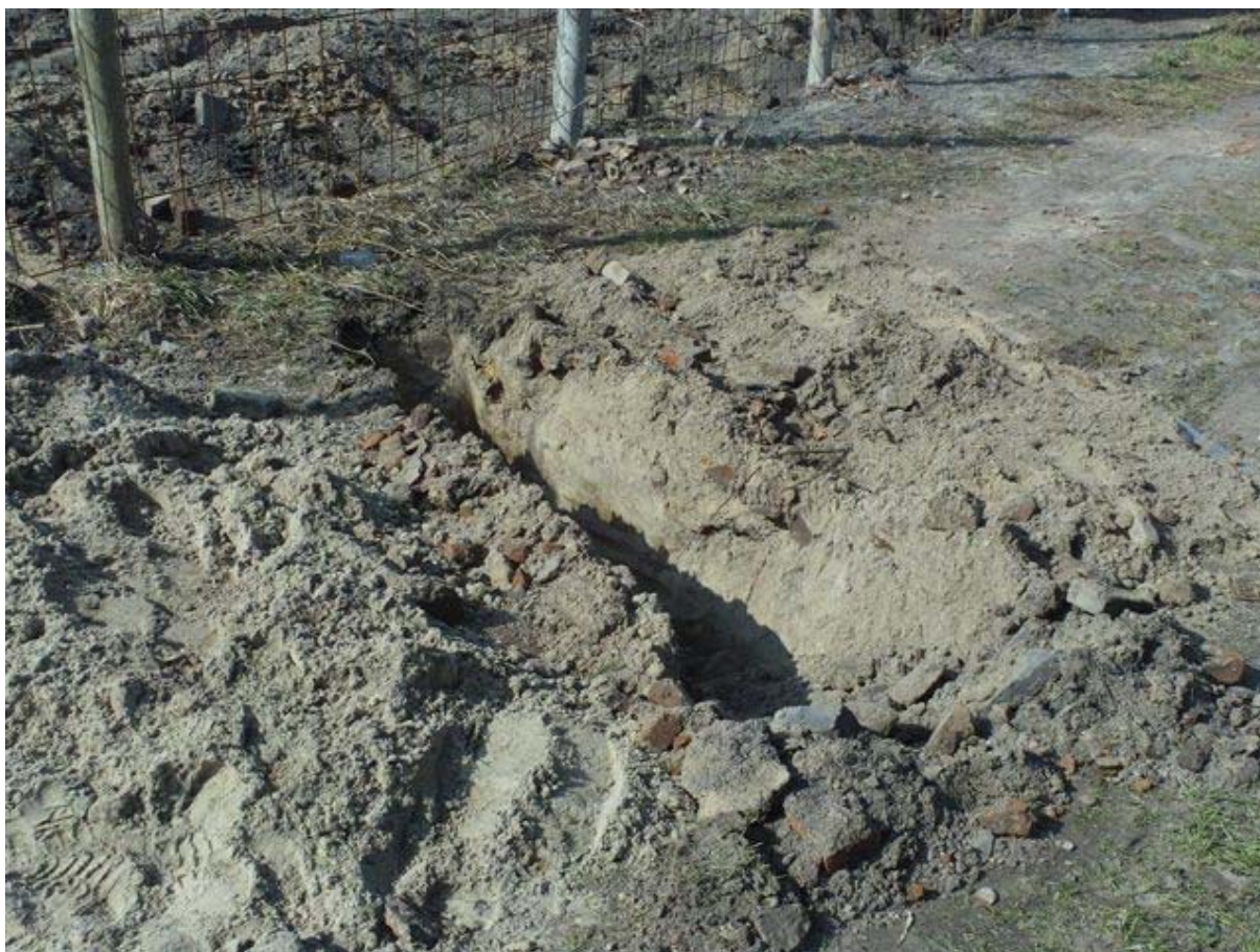
Foto 23: Duivallei te Katwijk, Asbestonderzoek
