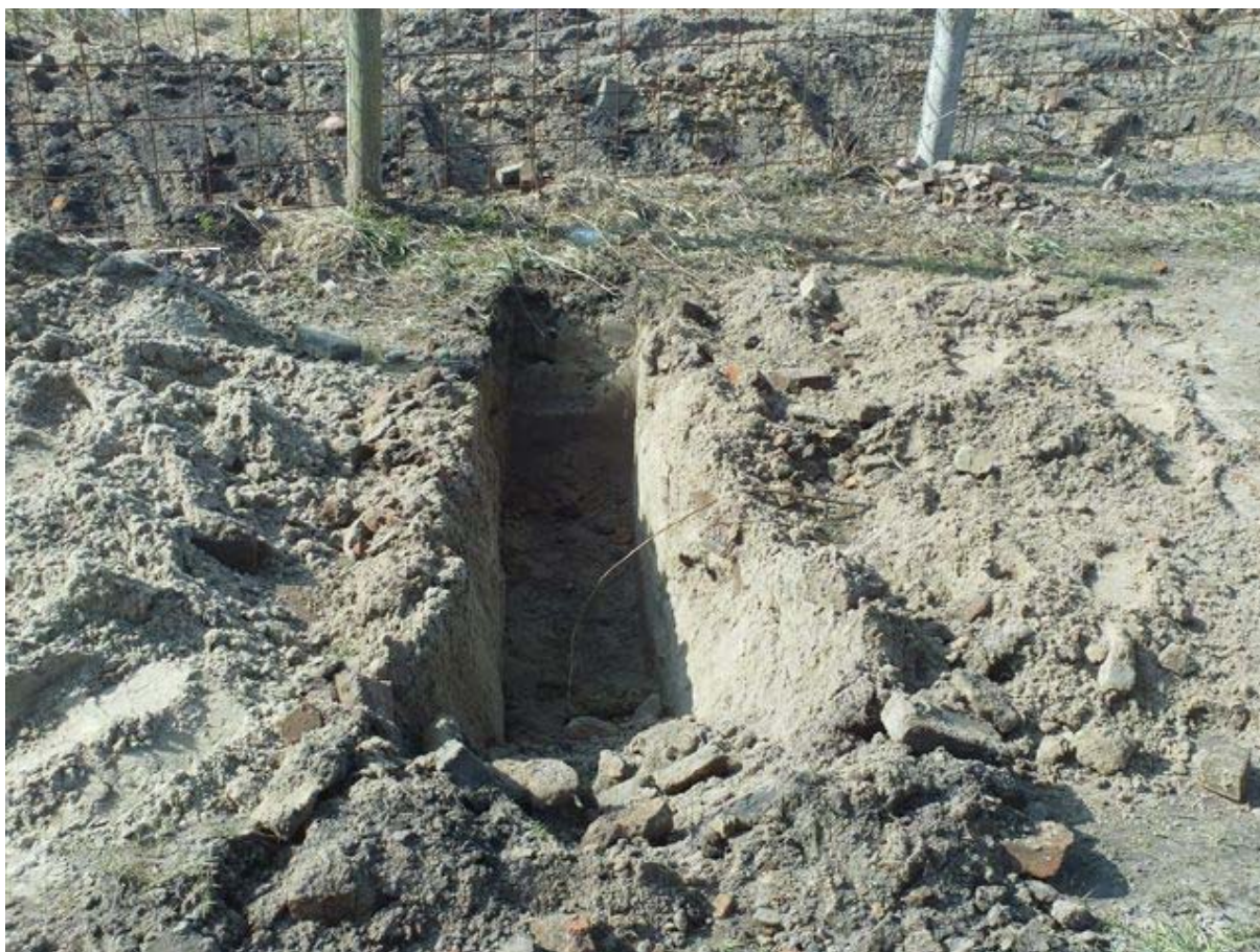
Foto 9: Duivallei te Katwijk, Asbestonderzoek
