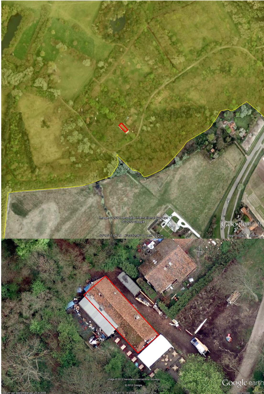
Figuur 20 Boven: ligging van het theehuis van de Pan van Persijn (rood) ten opzichte van de begrenzing van het Natura 2000-gebied Meijendel & Berkheide (geel). Onder: uitvergroting van het theehuis (rood) en de omliggende verharding Bron ondergrond: Google Earth
