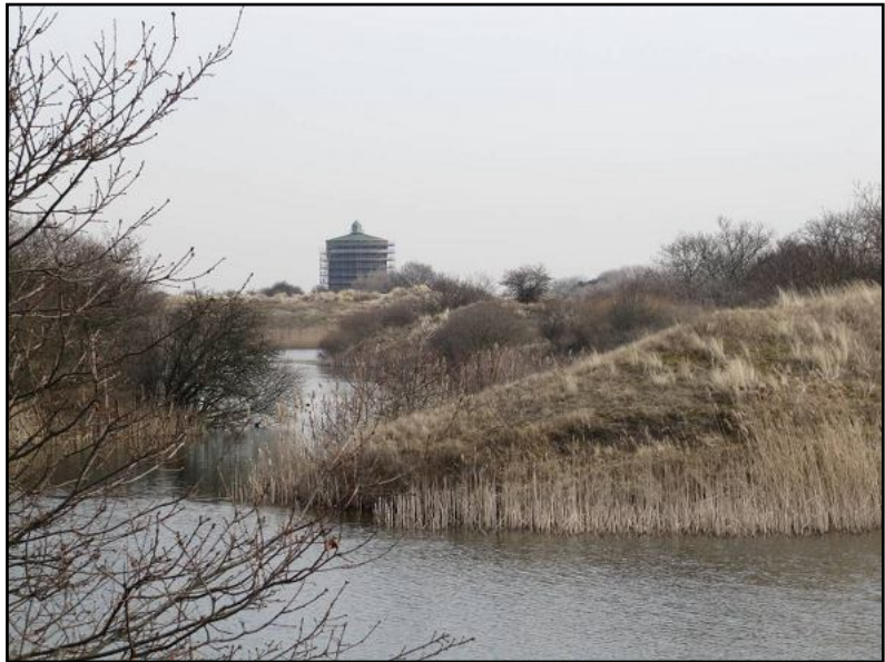
Infiltratieplas iets ten zuiden van Pompstation Katwijk met de watertoren van Katwijk.
