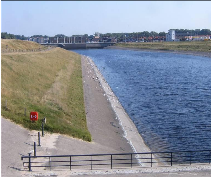
Uitwateringskanaal en pompgebouw
