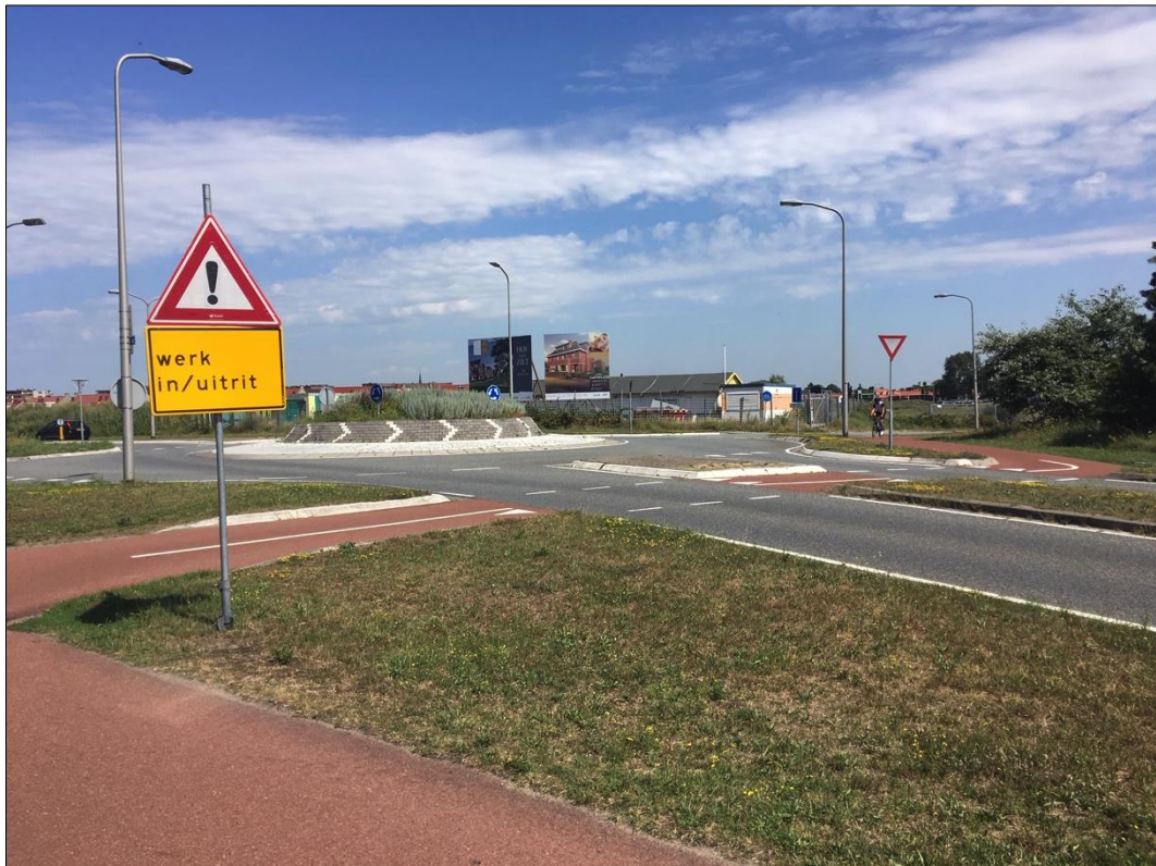
Zicht op de rotonde Kooltuinweg / N206 / N441 vanaf de zuidzijde richting noord.
