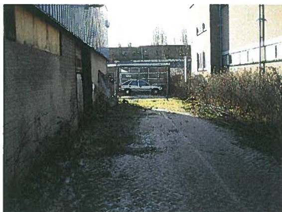
Foto 6: Klinkerverharding tussen wasplaats en achterterrein
