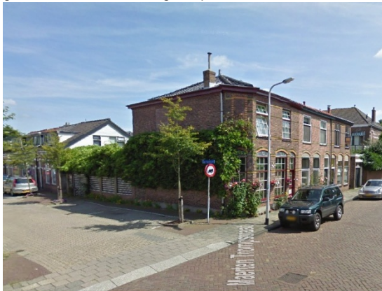
Foto 5. Ouder gebouw met aan de dakranden ingangsmogelijkheden, op 80 m afstand.
