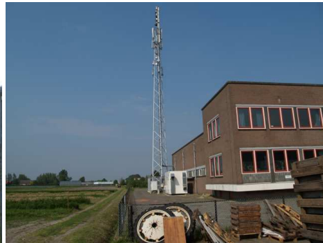
KPN gebouw met zendmast telefonie.
