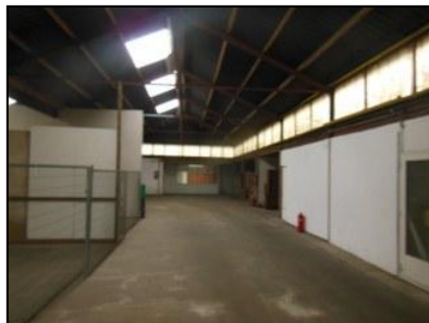
Figuur 4. Binnenzijde loods.
