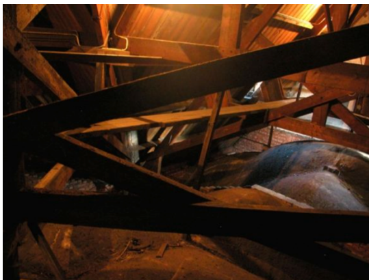
Afbeelding 7 en 8. De ruimte tussen het dak en de gewelven
