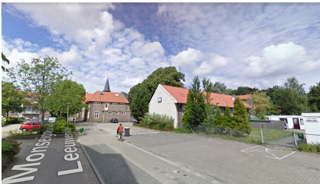
Figuur 8: Foto van het plangebied vanaf de Monseigneur van Leeuwenlaan in noordwestelijke richting (Google Maps Street View, augustus 2010).
