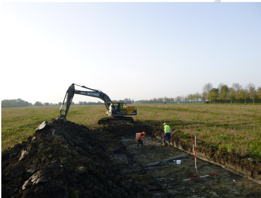
Afb. 1.2. Impressie van de omvang van het terrein, aan de rechterzijde ligt de Raadhuislaan en op de achtergrond de N506.
