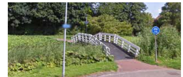
Reeds gerealiseerde bruggen, type C1 en C2
