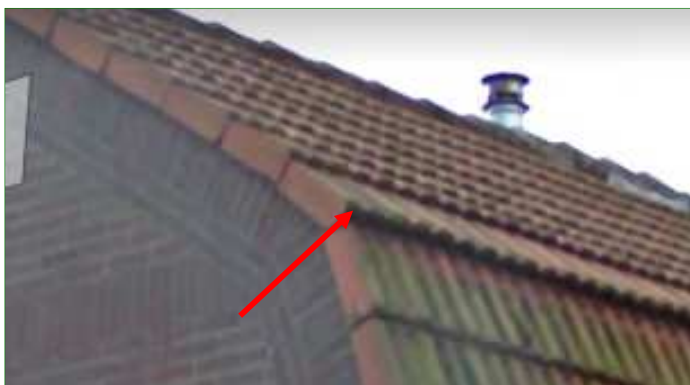
Invliegopening in het mansardedak op nr 28.
