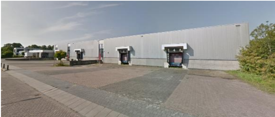
Figuur 2.1 Zicht op de bedrijfshal in het plangebied
