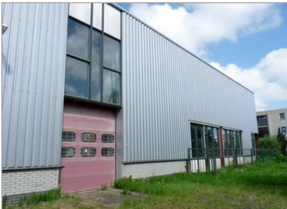
Figuur 9. Oostzijde plangebied, het bedrijfsgebouw met een laaddock, aan de oostzijde
