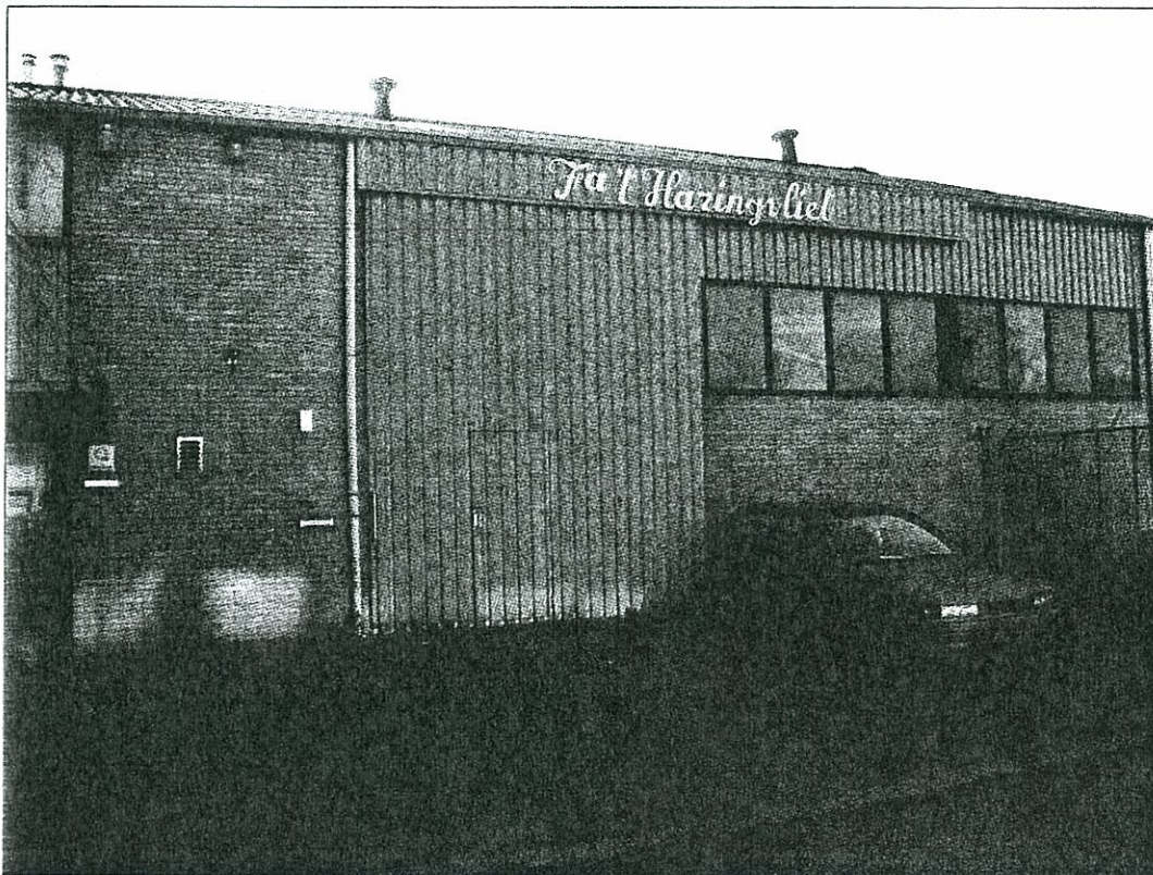
Foto 1: Molshoek 8 – Gevel bedrijfspand gezien vanaf de voorzijde
