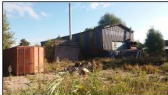
Foto 2: Container, stenen gebouw en loods in plangebied
