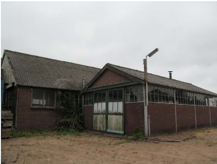
Opslagloods met dakrand
