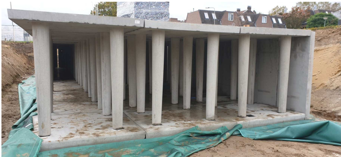
Figuur 17: Illustratie waterbergingsvoorziening Watertable Trewatin (bron: Website Trewatin).
