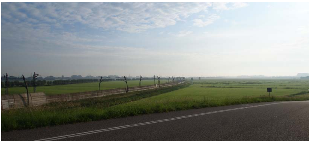
Afbeelding 3.13: de Betuweroute doorsnijdt het buitengebied ten noorden van Hardinxveld-Giessendam
