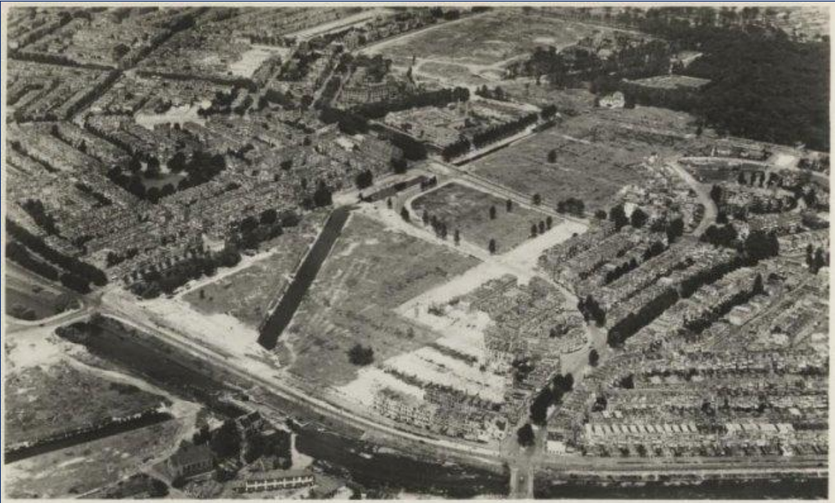
Figuur 5: Luchtfoto van de verwoestingen in Duinoord ter hoogte van het onderzoeksgebied. Op de voorgrond is het Afvoerkanaal waarneembaar. 18
