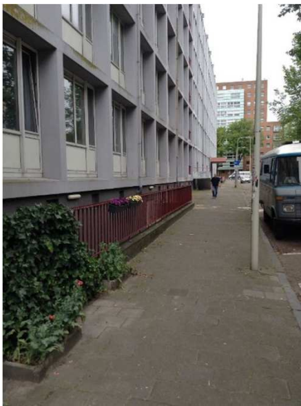
Locatie zijde Verhulstplein
