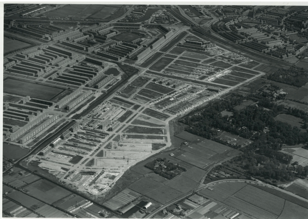
Afb. 7 Luchtfoto uit 1951 van de aanleg van Moerwijk. Onderaan het plangebied.
