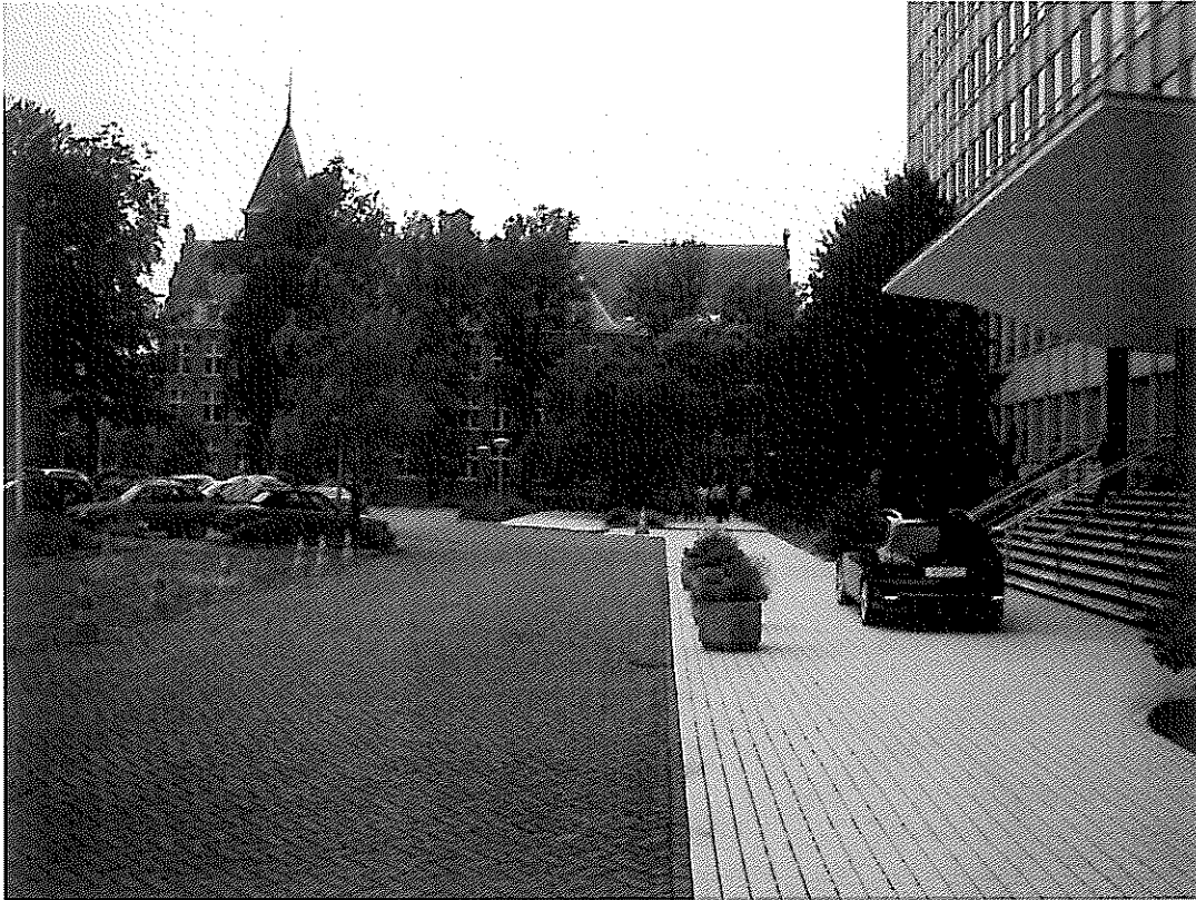
Centrale terreindeel bij ingang gebouw (in westelijke richting)
