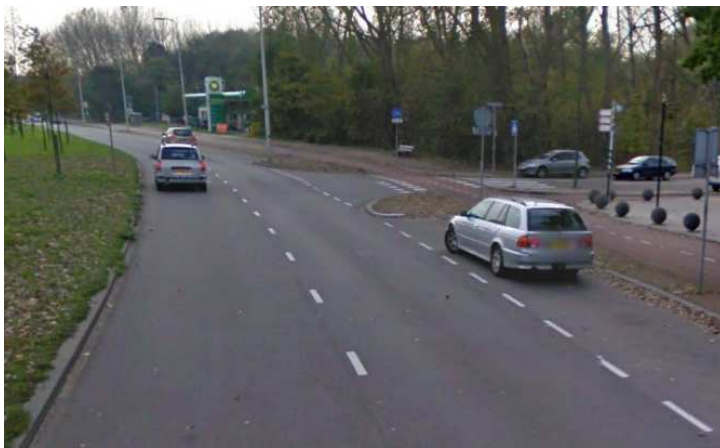
figuur 2.3 Huidig profiel Ockenburghstraat zonder aparte uitvoegstrook
