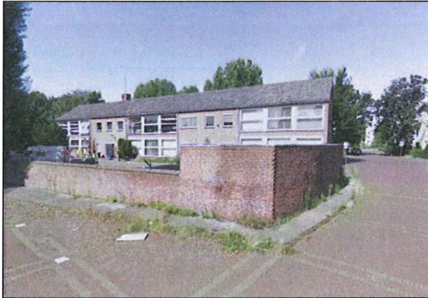
Foto 1: Te slopen pand met een vleermuis verblijf
