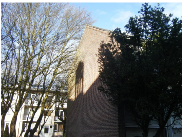
Foto 5: te slopen pand Grovenstinsstraat geschikt voor vlermuizen
