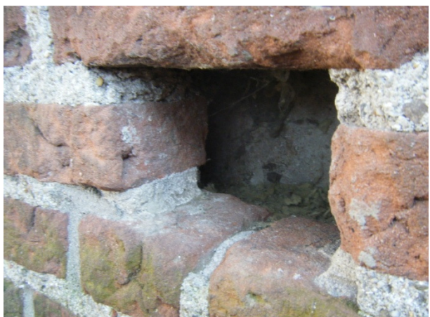
Foto 6: ruimte in de spouwmuur pand Grovenstinsstraat
