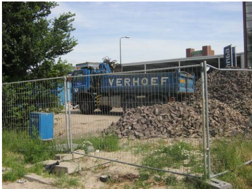
Foto 3: Het terrein wordt gebruikt als opslag van bouwmaterialen.
