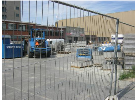
Foto 4: Het terrein is deels verhard met stelconplaten.
