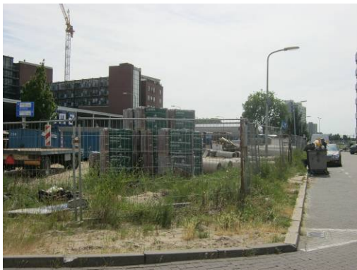
Foto 5: Zicht op de noordzijde van de onderzoekslocatie met rechts de Leeghwaterstaat.
